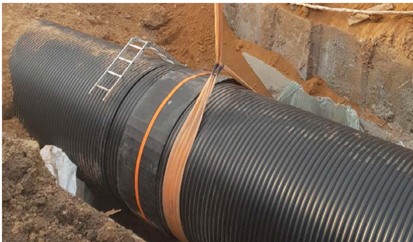
Каналізаційна труба, з'єднана термоусадковою муфтою
