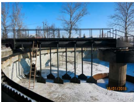
Армований полімерний міст-скребок на КОС м. Коломиї, Івано-Франківської області
