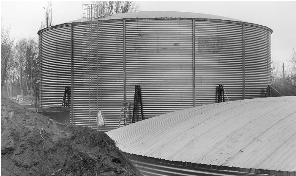
5000 м 3 , г. Славянск, монтаж емкости зимой
