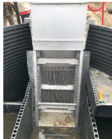
Грабельна решітка в колодязі з лотком на КОС м. Коломиї, Івано-Франківської області
