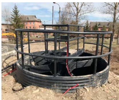
Пісколовка вертикальна (м. Коломия, Івано-Франківська область)
