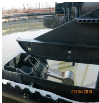
Армований полімерний міст-скребок на КОС м. Коломиї, Івано-Франківської області
