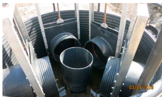
Пісколовка горизонтальна (м. Глиняни, Золочівського району)
