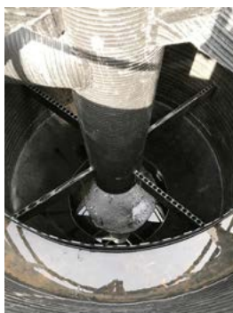
Пісколовка вертикальна (м. Коломия, Івано-Франківська область)
