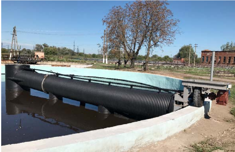
Полімерний скребок на КОС м. Львів
